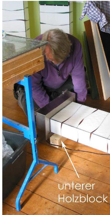
Abb. 6 - Unterlegen des unteren Holzblocks
