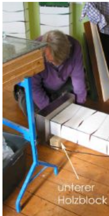
Abb. 7 - Unterlegen des unteren Holzblocks
